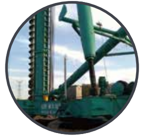
长螺旋桩机海上打桩
